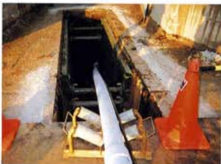
真空下水管推進工事 茨城県 境町
