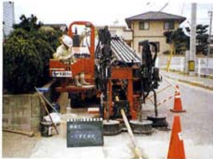
通信ケーブル推進工事 福岡県 福岡市
