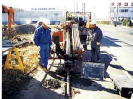
下水道(圧送)管推進工事 千葉県 千葉市
