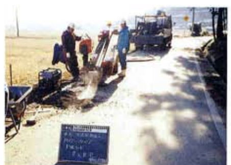
配水管推進工事 千葉県 多古町
