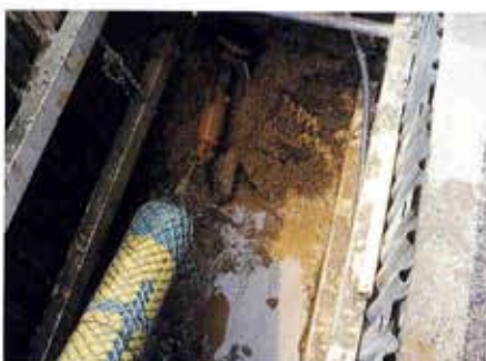
ガス管推進工事 宮城県 仙台市
