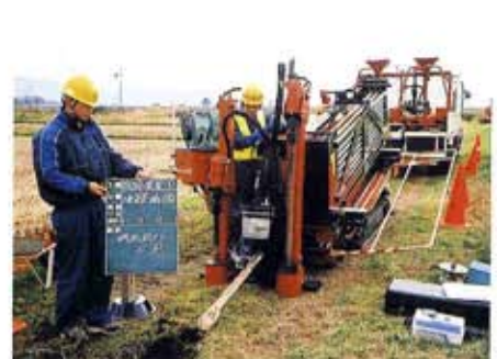
真空下水管推進工事 福島県 猪苗代町
