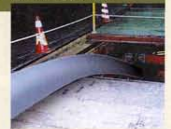
③パイプ引き込み
