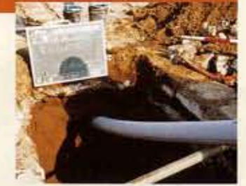
③パイプ引き込み
