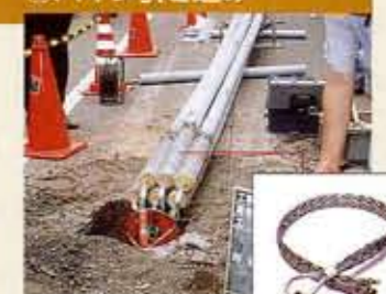
③パイプ引き込み
