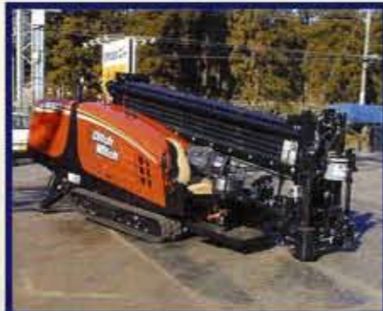
1.ドリルユニット据え付け
